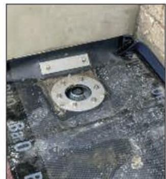
Haupt- und Notentwässerung auf dem Flachdach sind nach einem optimierten Verlege-Plan angeordnet. Mit den orangefarbenen Kappen sind die Notabläufe zudem gut zu erkennen. Ein Anstauwehr stellt sicher, dass die Notentwässerung nur bei entsprechend hoher Wasserbelastung beansprucht wird.
