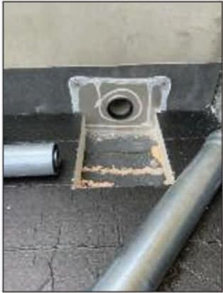
Mit den Loro-Rainstar-Abläufen lässt sich die Entwässerung in die Dämmebene legen.
