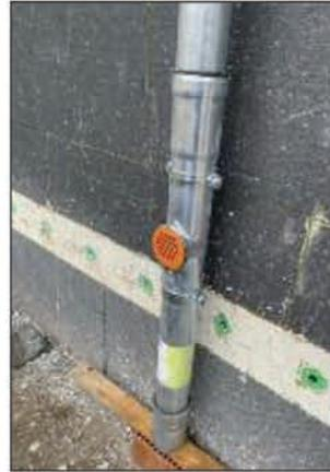
Sicherheit inklusive: Der „Loro HSU“ (Hochleistungs-Sicherheits-Überlauf) sorgt dafür, dass bei extremem Regen oder verstopften Abwasserkanälen kein Rückfluss nach oben erfolgt, sondern das Wasser auf die freie Fläche fließt.
