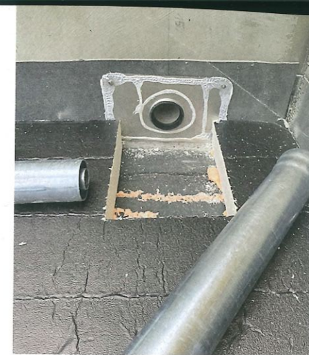
Mit den Loro-»Rainstar«-Abläufen lässt sich die Entwässerung in die Dämmebene legen.
