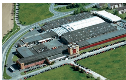
The LOROWERK in Bad Gandersheim
