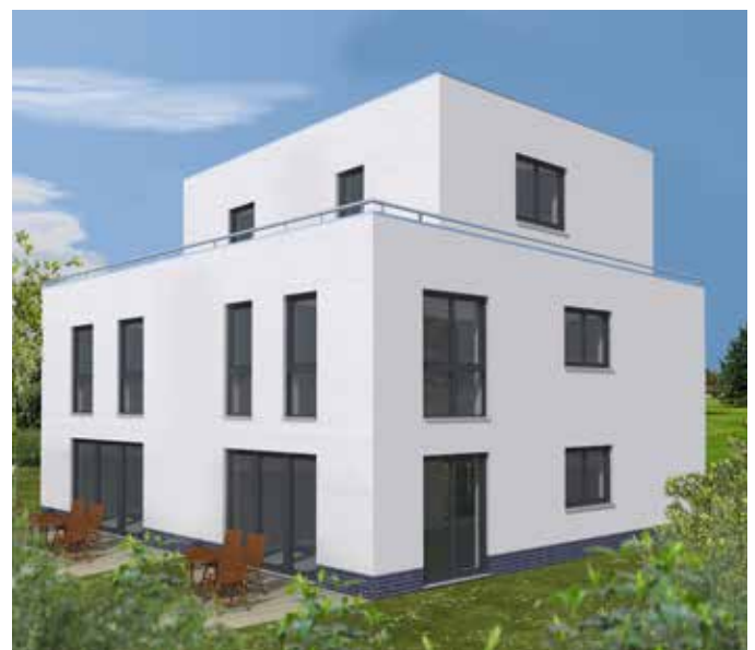
Bild 2. Keine Falleleitung in der Hauptansicht
