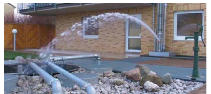
Bild 35. LORO-X Regenstandrohr mit HSÜ bei Rückstau aus der Grundleitung in Funktion
