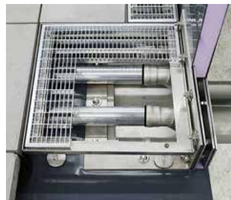
Bild 29. Notentwässerung der Dachterrassenentwässerung über aufgeständerte Gitterroste
